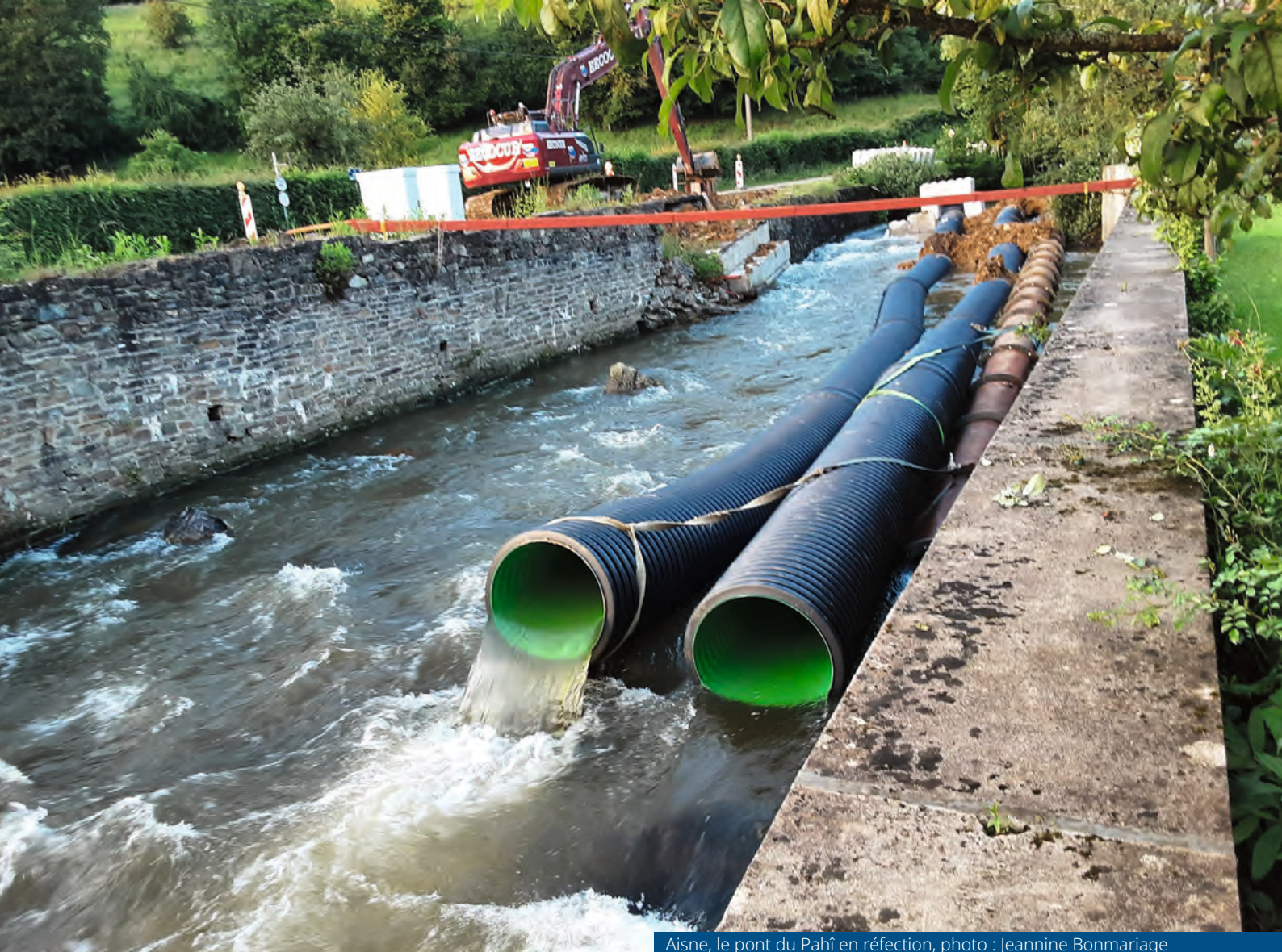
Aisne, le pont du Pahî en réfection, photo : Jeannine Bonmariage
