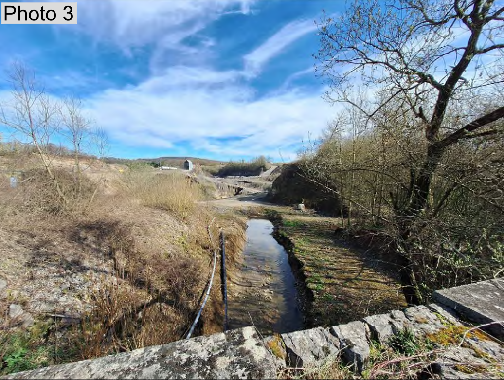
PHOTO 3 : Le déversoir d'orage, vu depuis le "pont de Tour" : le ruisseau de Tour se dirige vers la carrière et passe en canalisation enterrée au centre de la photo. En période de crue, l'excédent de débit part à gauche, vers la fosse de carrière.
