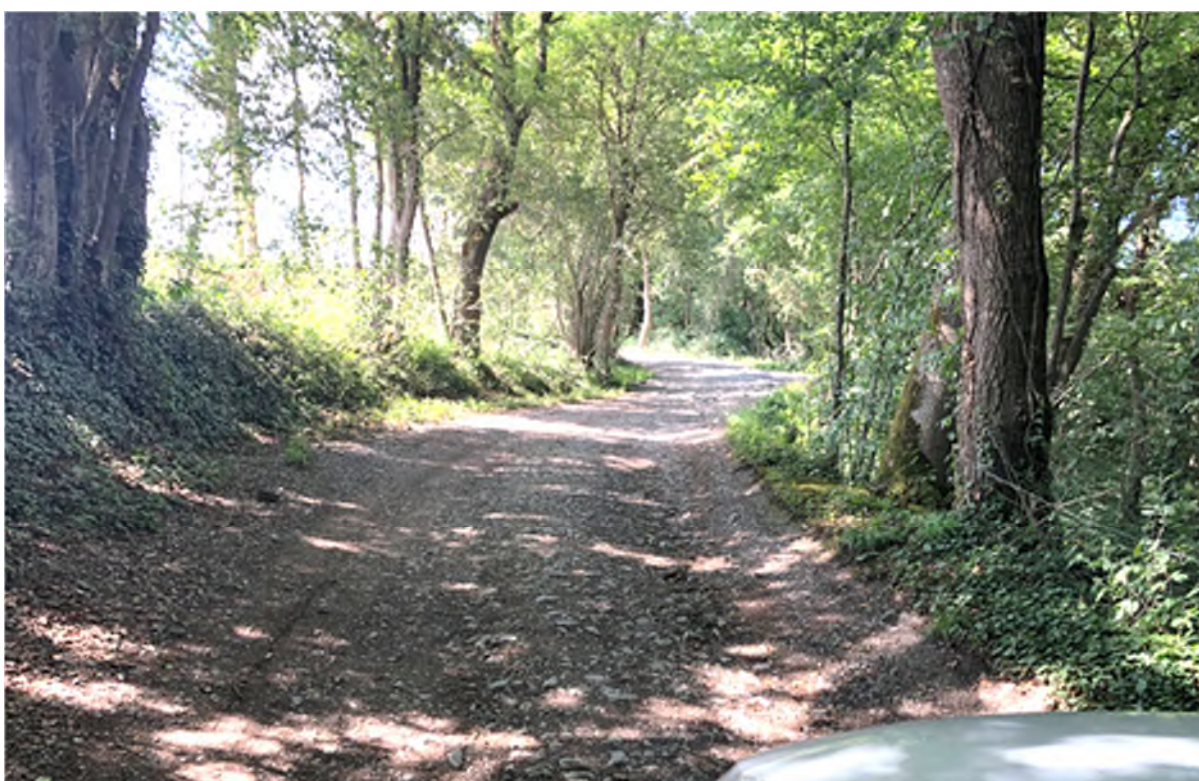
PHOTO 2 : le chemin n°6 dans la montée entre des alignements d'arbres. Forte pente, virages, largeur 3 m, empièchement continu mais pente forte et virages : impraticable par les convois agricoles lourds et les camions.
